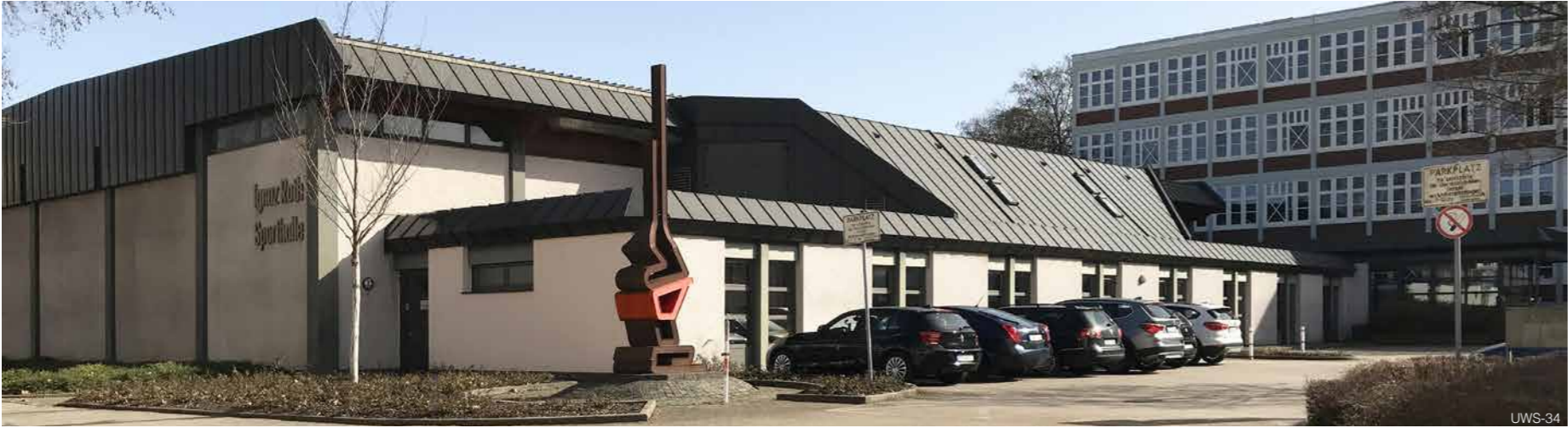
Ignaz-Roth-Sporthalle Zweibrücken, Cortenstahl, partiell farbig lackiert.
